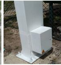
Adecuado Estado de Zapatas
