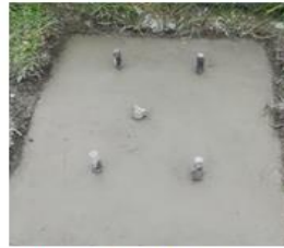
Implementación de Zapatas
